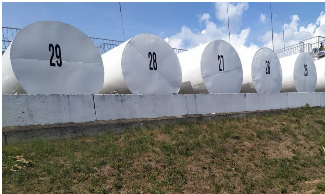
Рисунок 1 – Общий вид резервуаров РГС-50
