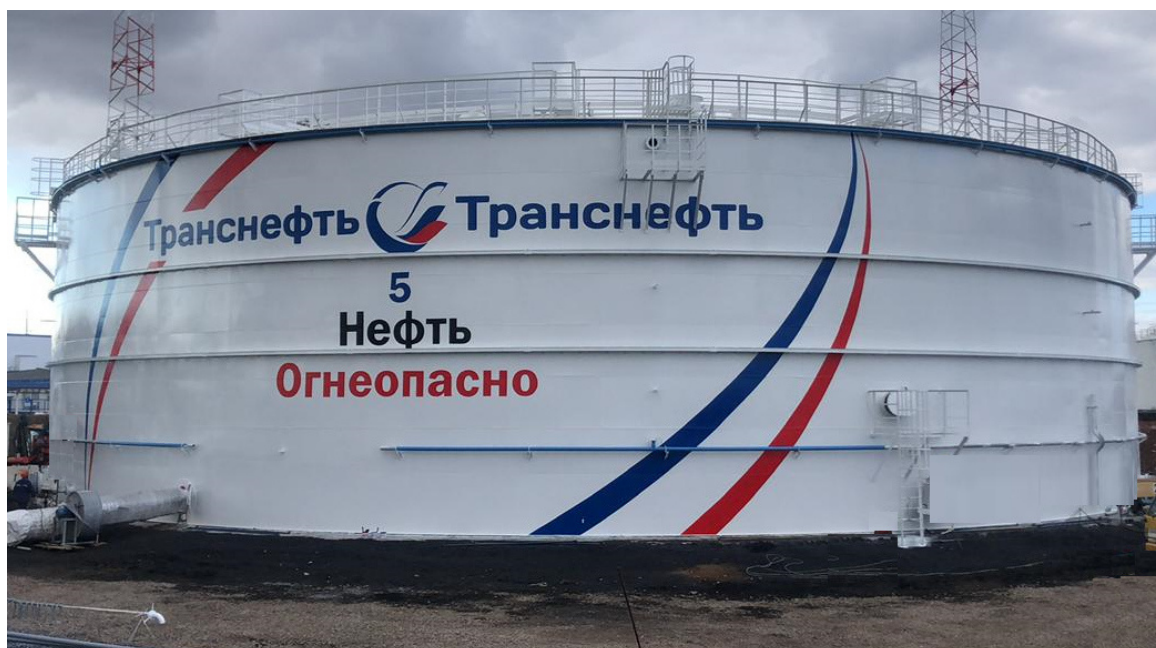
Рисунок 1 – Общий вид резервуара РВСП-20000
