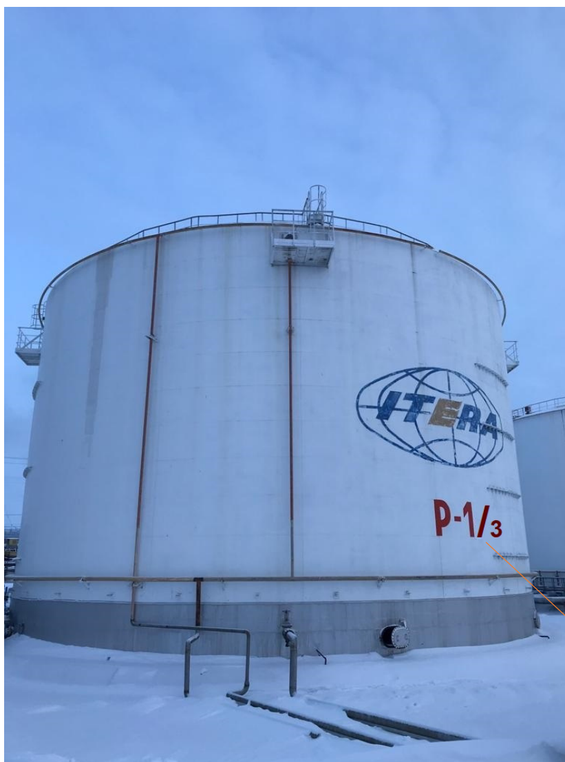
Рисунок 3 - Общий вид резервуара вертикального стального цилиндрического РВС-10000 заводской номер Р-1/3 с указанием места нанесения заводского номера
