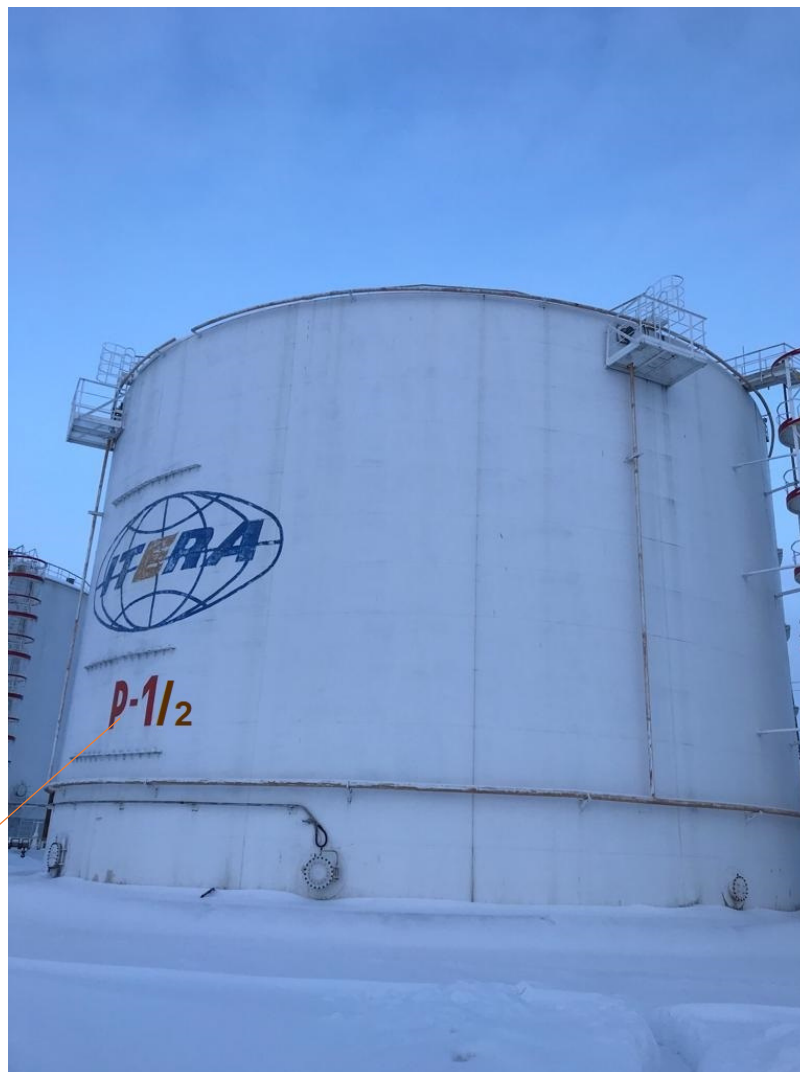
Рисунок 2 - Общий вид резервуара вертикального стального цилиндрического РВС-10000 заводской номер Р-1/2 с указанием места нанесения заводского номера
