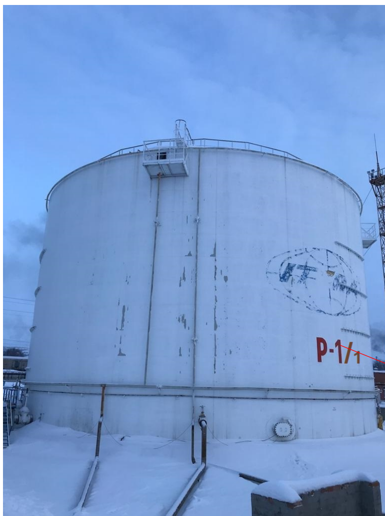
Рисунок 1 - Общий вид резервуара вертикального стального цилиндрического РВС-10000 заводской номер Р-1/1 с указанием места нанесения заводского номера
