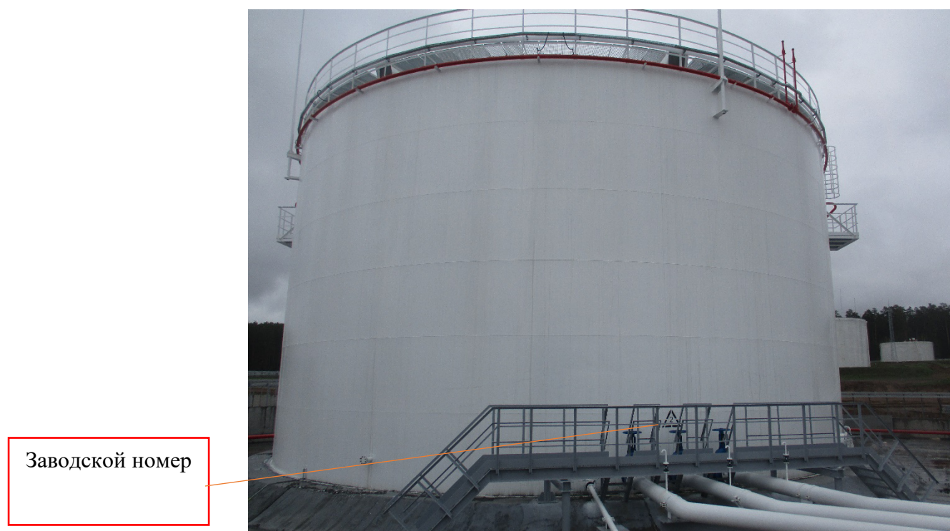
Рисунок 2 - Общий вид резервуара вертикального стального цилиндрического РВСП-5000 заводской номер 2 с указанием места нанесения заводского номера
