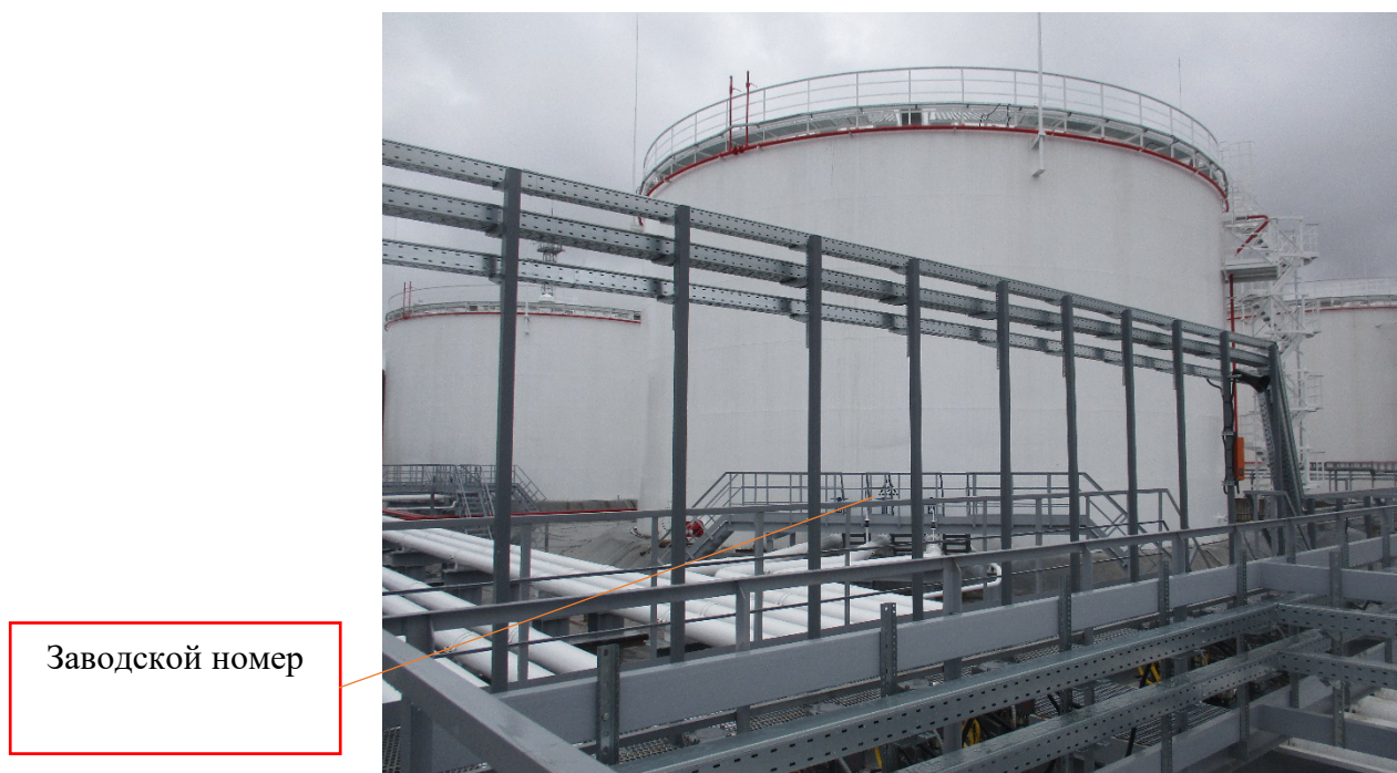
Рисунок 5 - Общий вид резервуара вертикального стального цилиндрического РВСП-5000 заводской номер 5 с указанием места нанесения заводского номера
