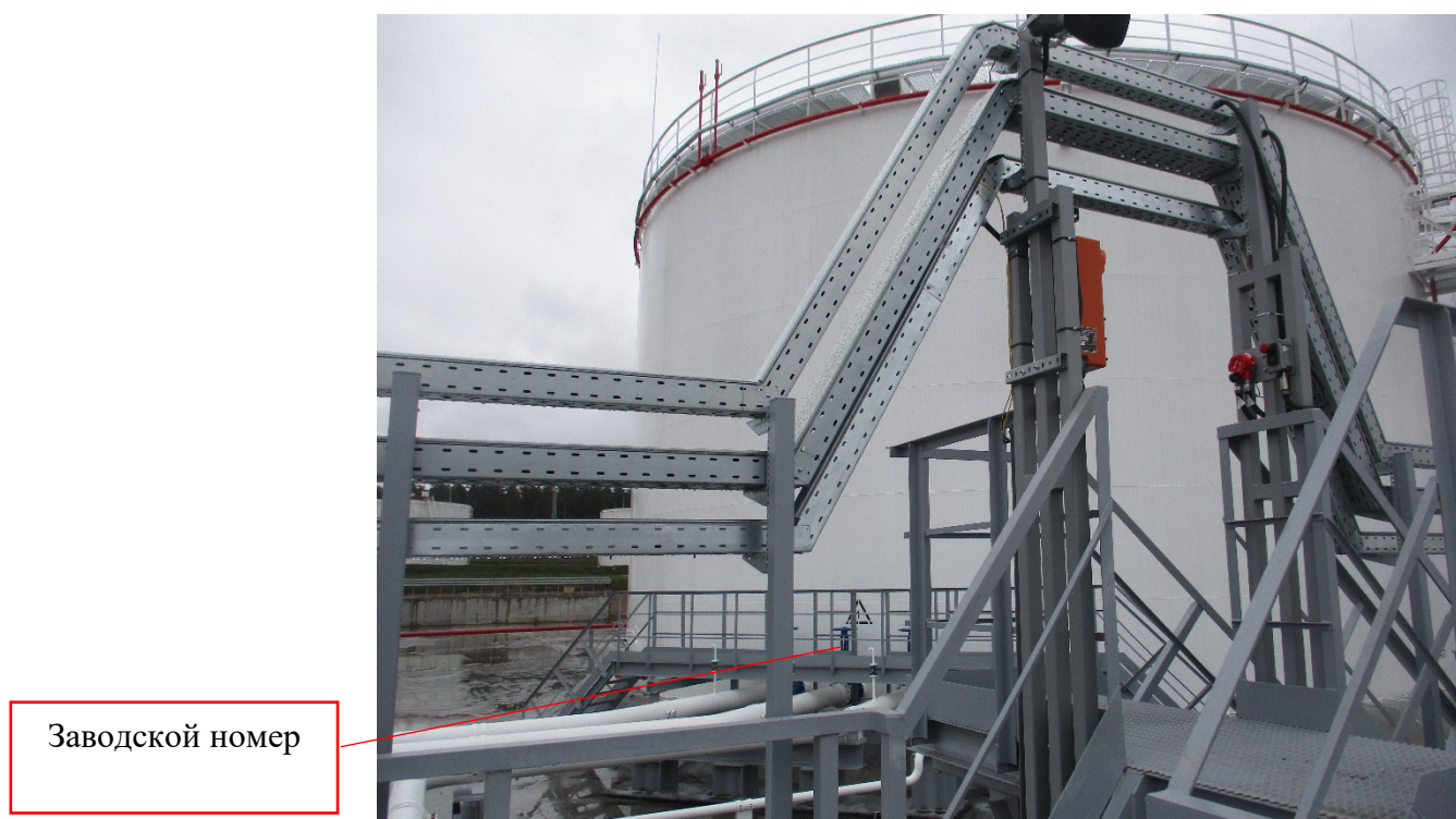
Рисунок 1 - Общий вид резервуара вертикального стального цилиндрического РВСП-5000 заводской номер 1 с указанием места нанесения заводского номера
