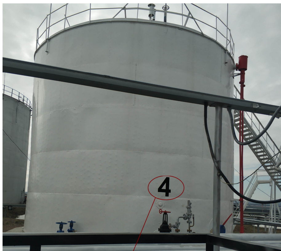
Рисунок 1 – Общий вид резервуара РВС-400 с указанием места нанесения заводского номера
