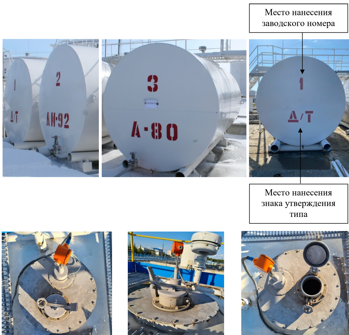
Рисунок 1 – Общий вид резервуаров с указанием места нанесения знака утверждения типа, места нанесения заводского номера
