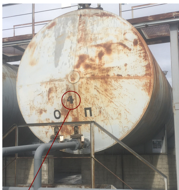
Рисунок 1 – Общий вид резервуара РГС-100 № 3 с указанием места нанесения заводского номера
