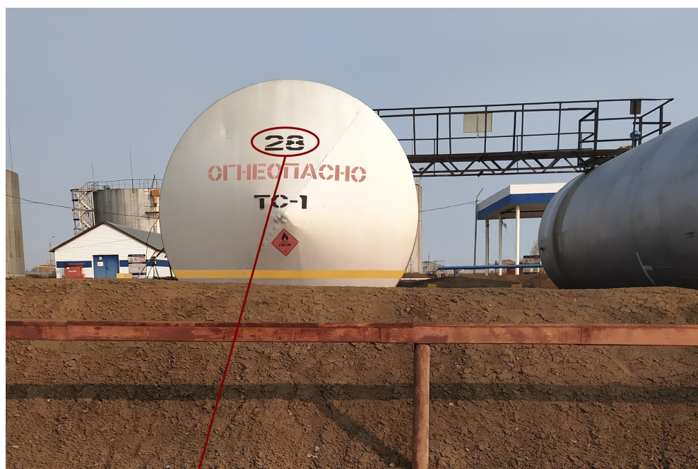
Рисунок 1 – Общий вид резервуара РГС-75 №27 с указанием места нанесения заводского номера
