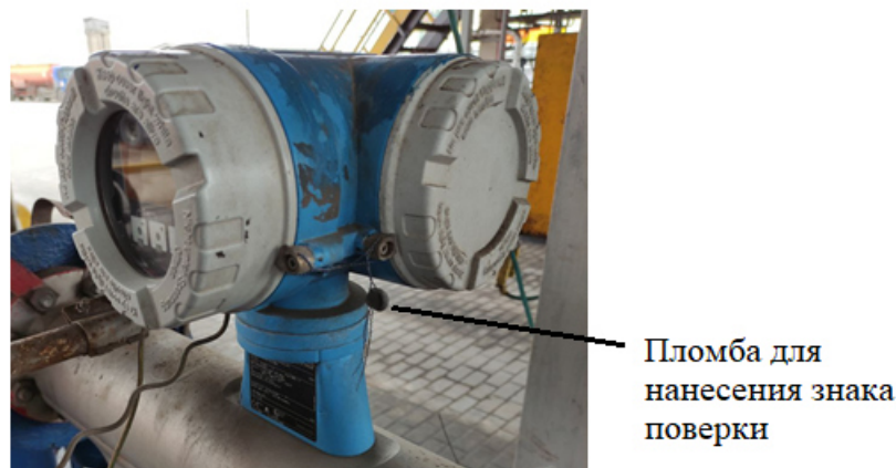
Рисунок 5 – Схема пломбировки электронного преобразователя 83 Promass
