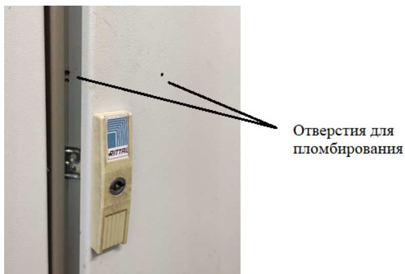
Рисунок 4 – Схема пломбировки шкафа СОИ
