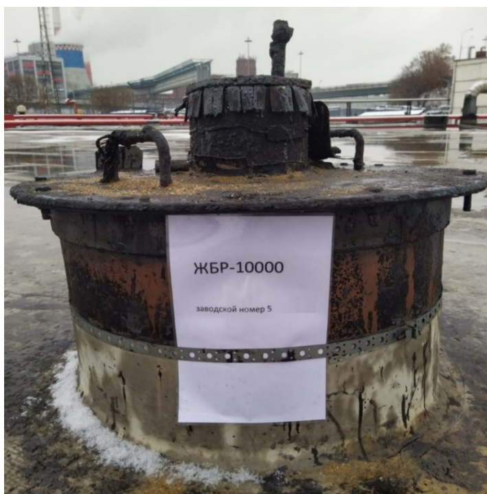
Рисунок 2 – Общий вид резервуара ЖБР-10000
