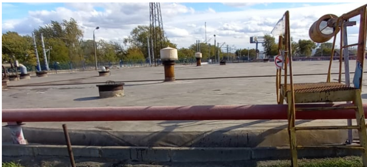
Рисунок 1 – Общий вид резервуара ЖБР-10000
