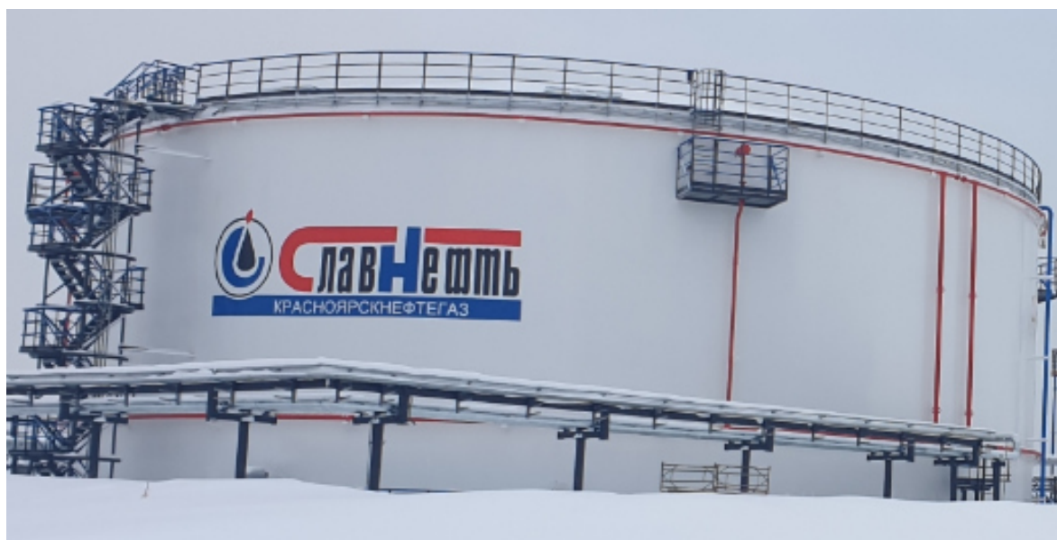
Рисунок 1 – Общий вид резервуара РВС-10000
