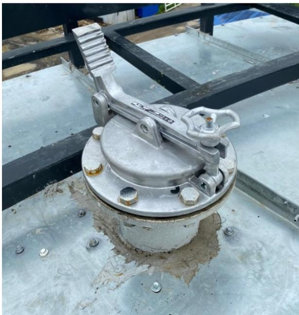
Рисунок 3 – Фото замерного люка резервуаров РВС-700
