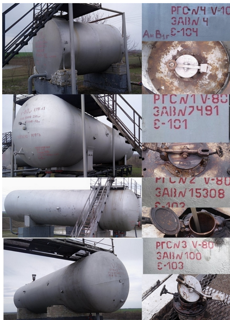
Рисунок 1 – Общий вид резервуаров стальных горизонтальных цилиндрических РГС (РГС-10, РГС-80) их горловин и заводских номеров
