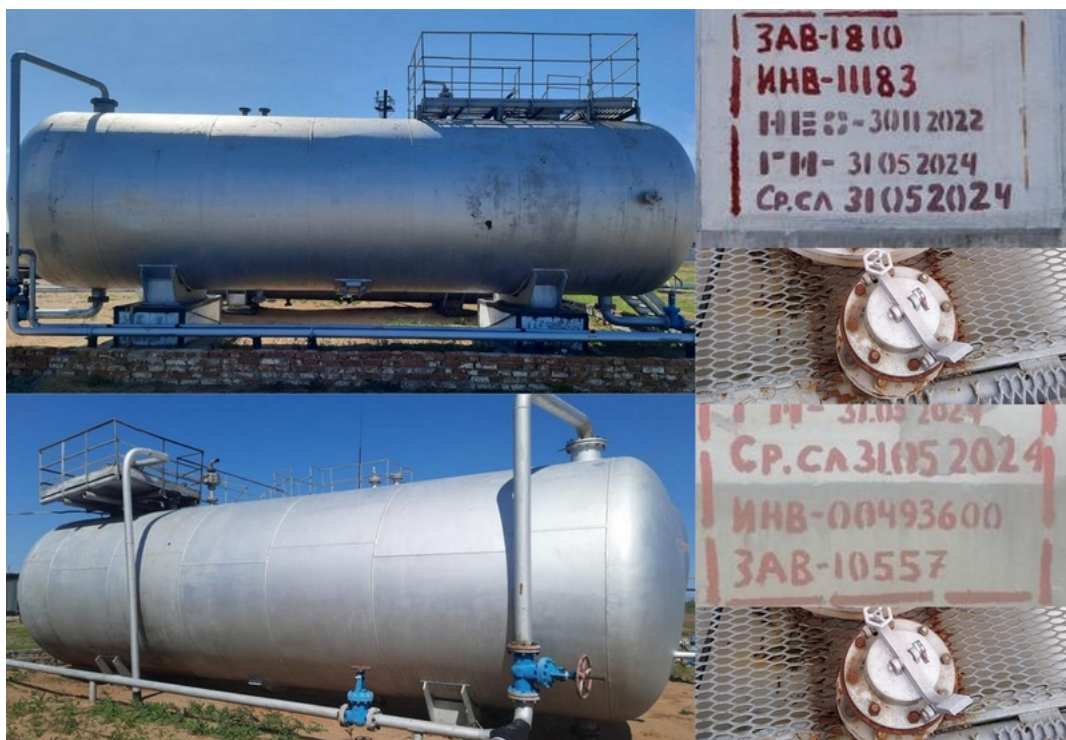
Рисунок 1 – Общий вид резервуаров стальных горизонтальных цилиндрических РС-72 их горловин и заводских номеров
