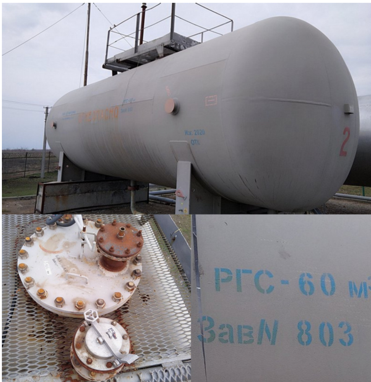
Рисунок 1 – Общий вид резервуара горизонтального цилиндрического РГС-60, горловины и заводского номера
