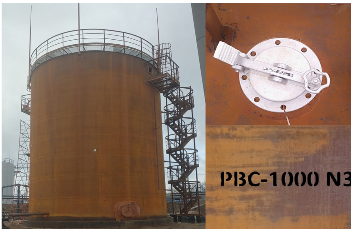
Рисунок 1 – Общий вид резервуара стального вертикального цилиндрического РВС-1000, горловины и заводского номера
