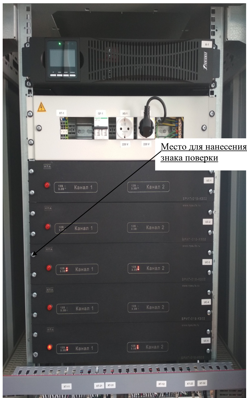
Рисунок 2 – Схема пломбировки контроллера БРИГ-015-К302
