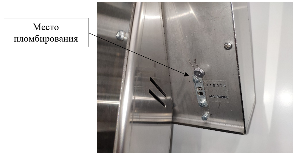
Рисунок 2 – Схема пломбирования от несанкционированного доступа
