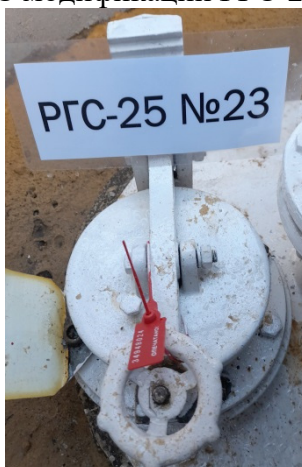
Рисунок 6 – Фотография горловины и заводского номера резервуара стального горизонтального цилиндрического РГС модификации РГС-25, заводской номер 23
