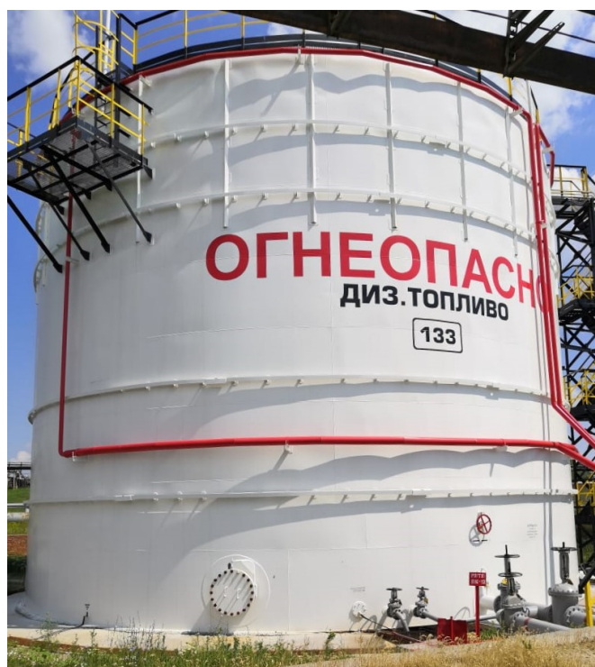
Рисунок 1 – Общий вид резервуаров РВС-2000
