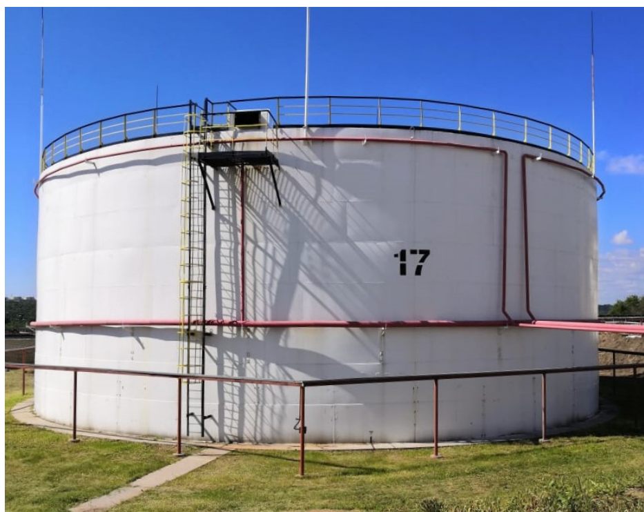
Рисунок 1 – Общий вид резервуаров РВС-8000
