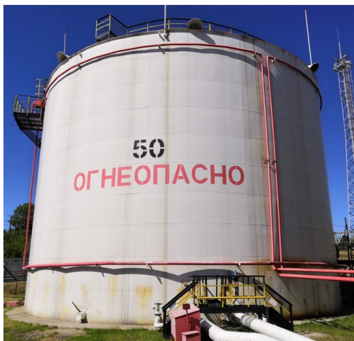
Рисунок 1 – Общий вид резервуаров РВСП-5000
