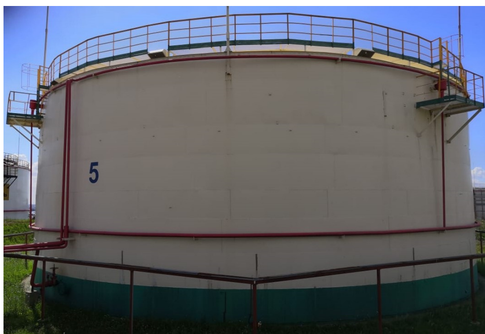
Рисунок 1 – Общий вид резервуаров РВСП-8000
