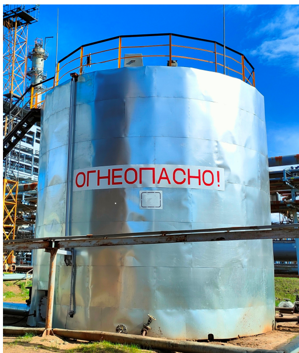
Рисунок 1 – Общий вид резервуара РВС-300
