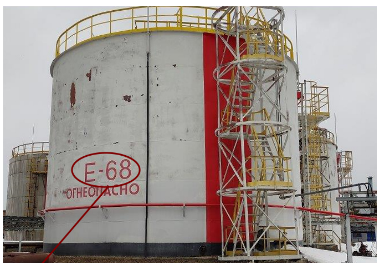
Рисунок 1 – Общий вид резервуара РВС-1000 № Е-67 с указанием места нанесения заводского номера
