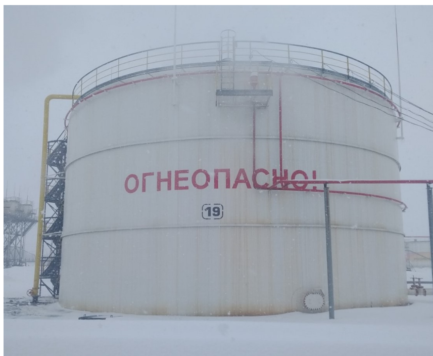
Рисунок 1 – Общий вид резервуаров РВС-5000
