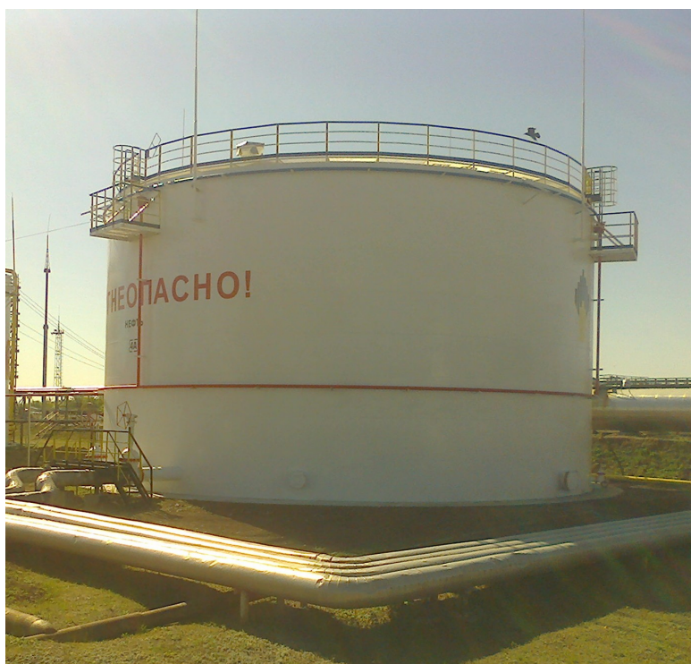
Рисунок 1 – Общий вид резервуара РВС-5000
