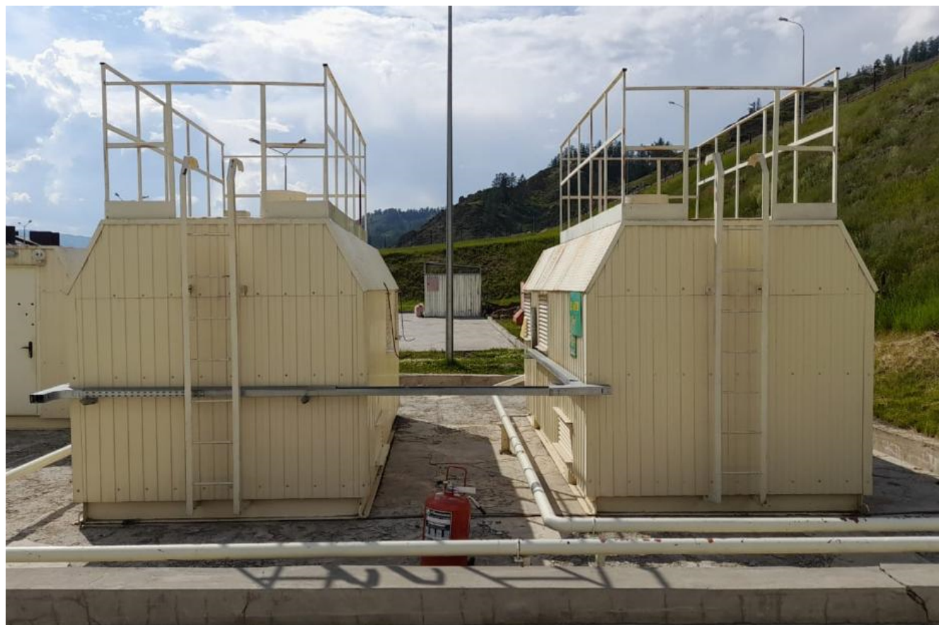
Рисунок 1 – Место расположения резервуаров
