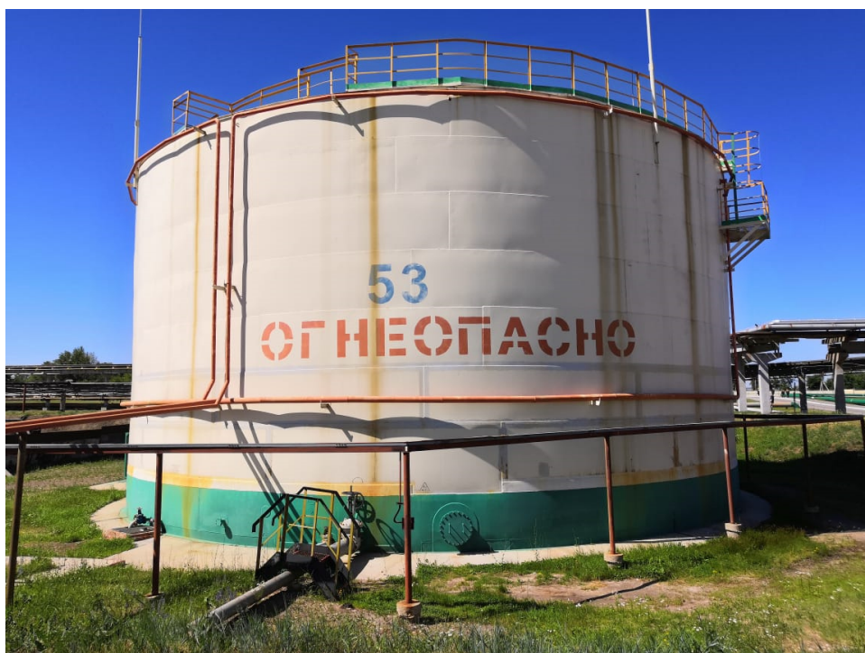
Рисунок 1 – Общий вид резервуаров РВС-5000
