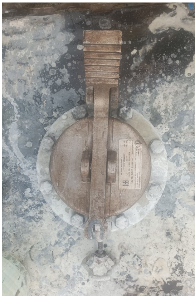
Рисунок 3 – замерной люк РВС-2000
