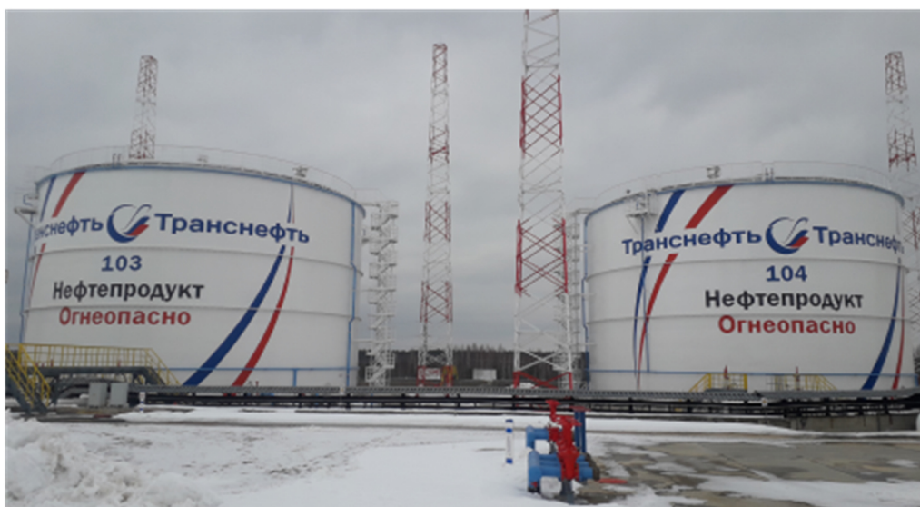
Рисунок 2 – Общий вид резервуаров стальных вертикальных цилиндрических РВС-10000, заводские №№ 103, 104
