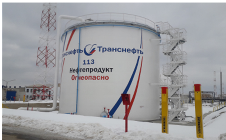
Рисунок 1 – Общий вид резервуара стального вертикального цилиндрического РВС-2000, заводской № 113
