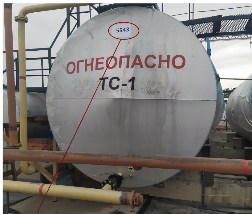
Рисунок 1 – Общий вид резервуара РГС-50 №4310 с указанием места нанесения заводского номера
