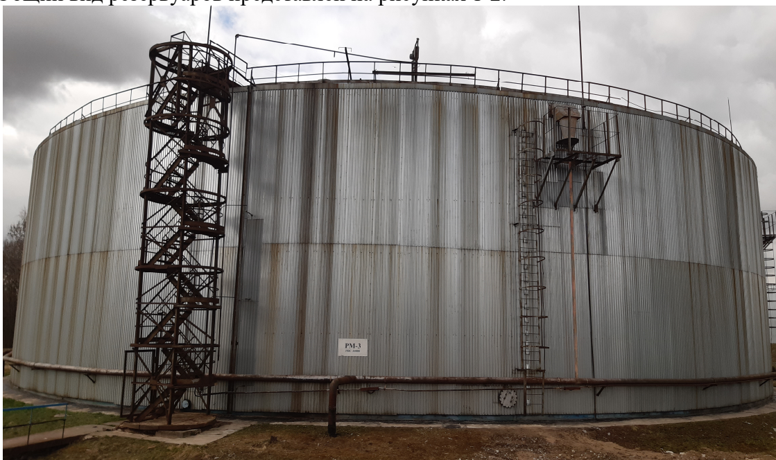
Рисунок 1 - Общий вида резервуара № РМ-3
