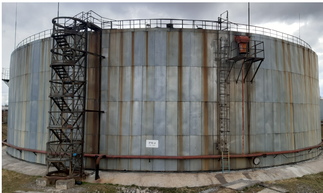
Рисунок 2 - Общий вида резервуара № РМ-4
