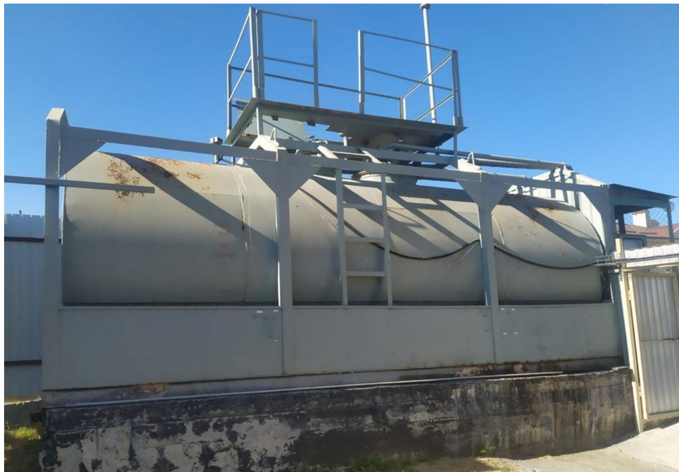
Рисунок 2 – Общий вид резервуара РГС-20
