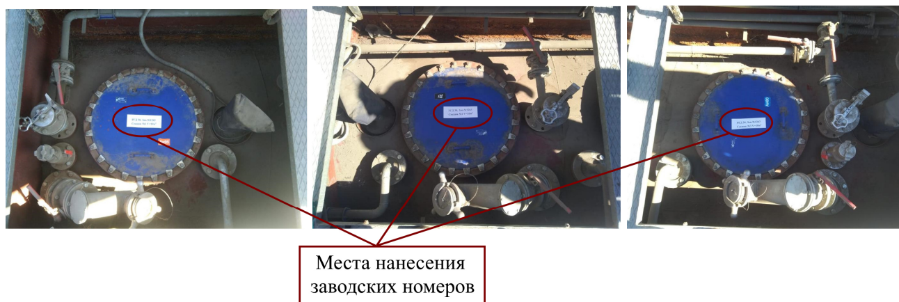
Рисунок 2 – Общий вид резервуара РГД-30(10+10+10) №1263 с указанием мест нанесения заводских номеров
