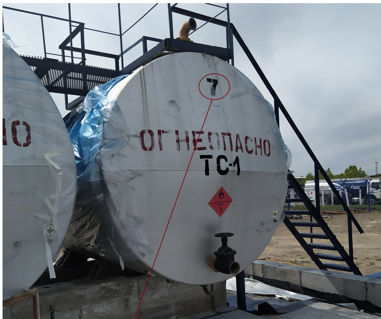
Рисунок 1 – Общий вид резервуара РГС-25 №7 с указанием места нанесения заводского номера
