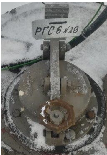
Рисунок 4 – Фотография горловины и заводского номера резервуара стального горизонтального цилиндрического РГС, модификации РГС-6, заводской номер 28
