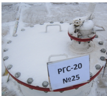
Рисунок 7 – Фотография горловины и заводского номера резервуара стального горизонтального цилиндрического РГС, модификации РГС-20, заводской номер 25
