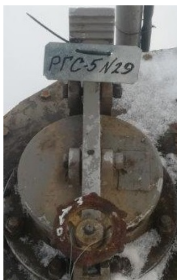
Рисунок 3 – Фотография горловины и заводского номера резервуара стального горизонтального цилиндрического РГС, модификации РГС-5, заводской номер 29
