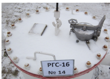
Рисунок 5 – Фотография горловины и заводского номера резервуара стального горизонтального цилиндрического РГС, модификации РГС-16, заводской номер 14
