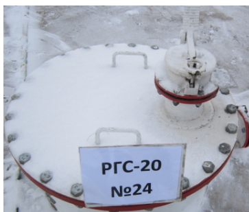
Рисунок 6 – Фотография горловины и заводского номера резервуара стального горизонтального цилиндрического РГС, модификации РГС-20, заводской номер 24
