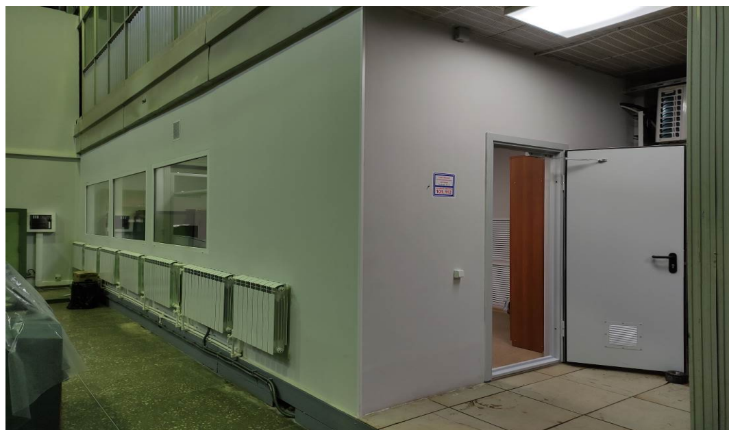
Рисунок 13 – Помещение операторской (место расположения РМО). Вид общий
