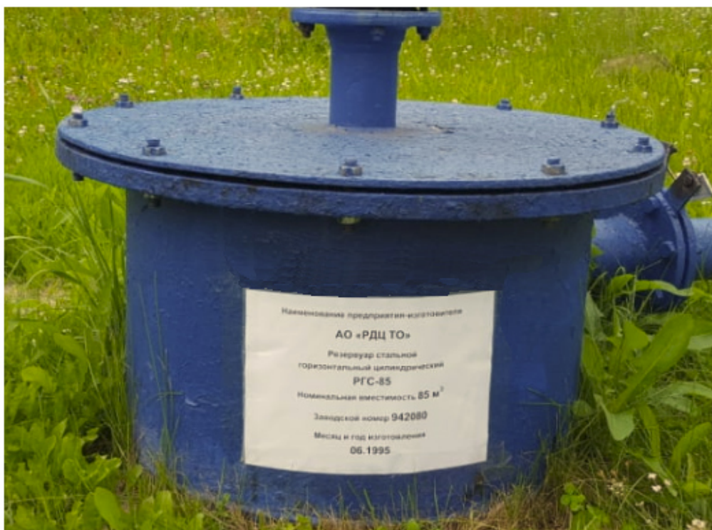
Рисунок 4 – Маркировочная табличка резервуара РГС-85
