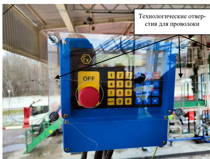
Рисунок 1 – Вид лицевой стороны контроллеров, дозирующих Batching Master и Batch Counter
