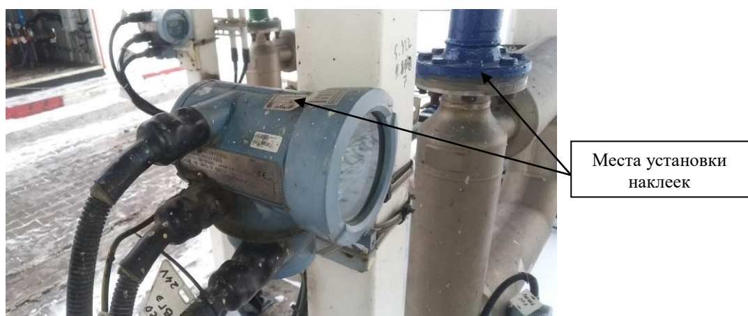
Рисунок 5 – Схема установки наклейки для защиты от несанкционированного доступа электронного преобразователя 2700 и на фланцевом соединении первичного преобразователя модели СМФ 300
