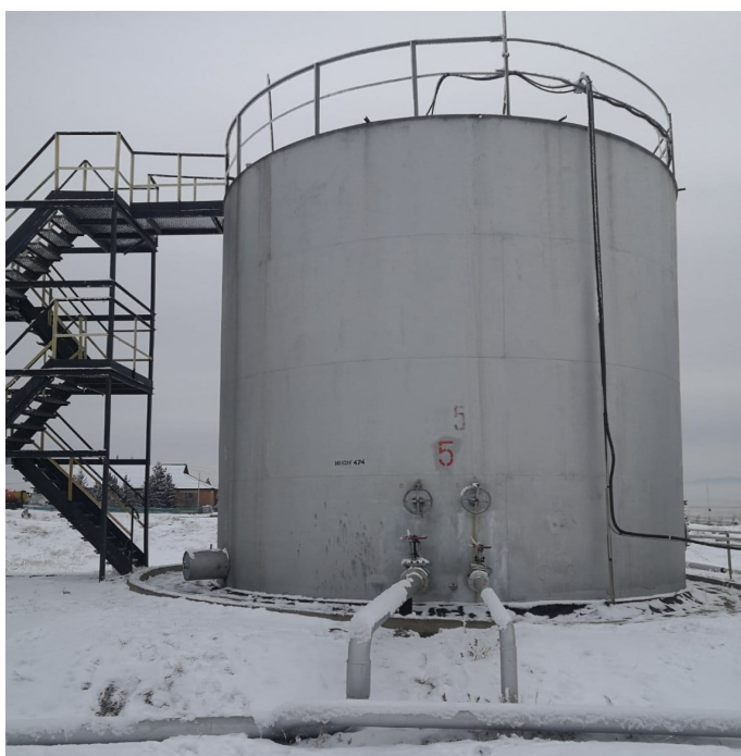
Рисунок 1 – Общий вид резервуаров РВС-200
