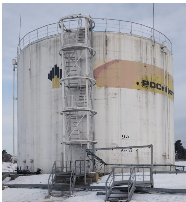
Рисунок 1 – Общий вид резервуаров РВС-2000
