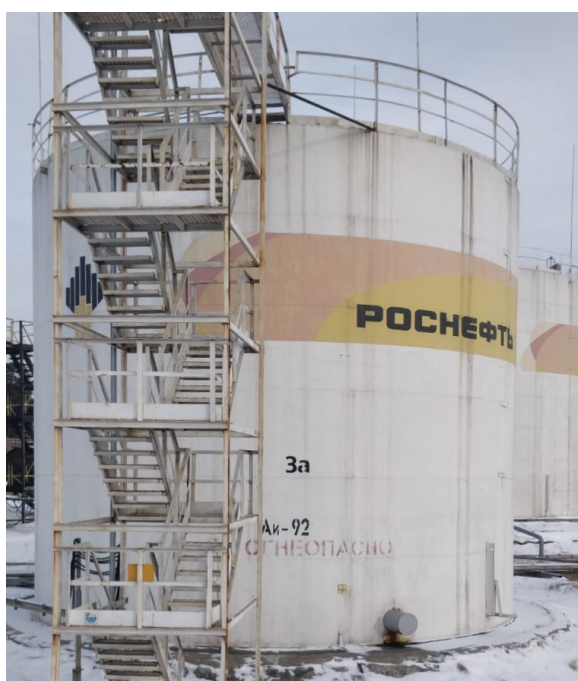
Рисунок 1 – Общий вид резервуара РВС-700
