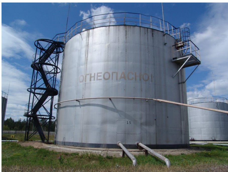
Рисунок 1 – Общий вид резервуаров РВС-1000
