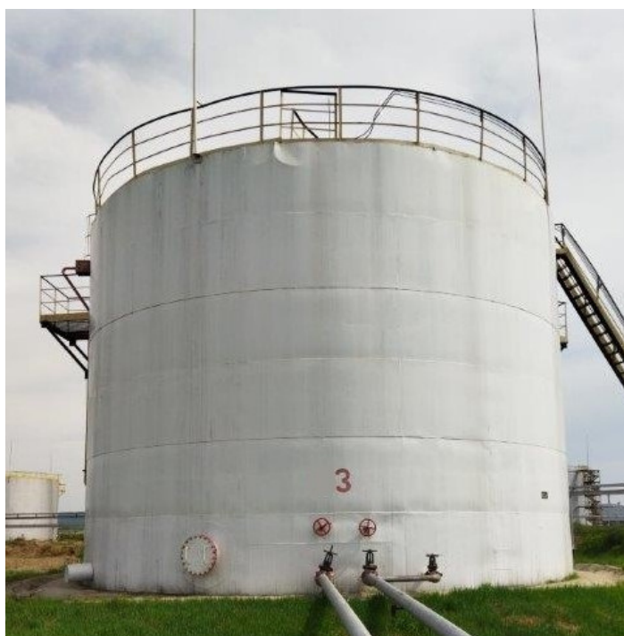
Рисунок 1 – Общий вид резервуаров РВС-1000
