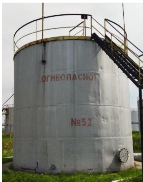
Рисунок 1 – Общий вид резервуаров РВС-200
