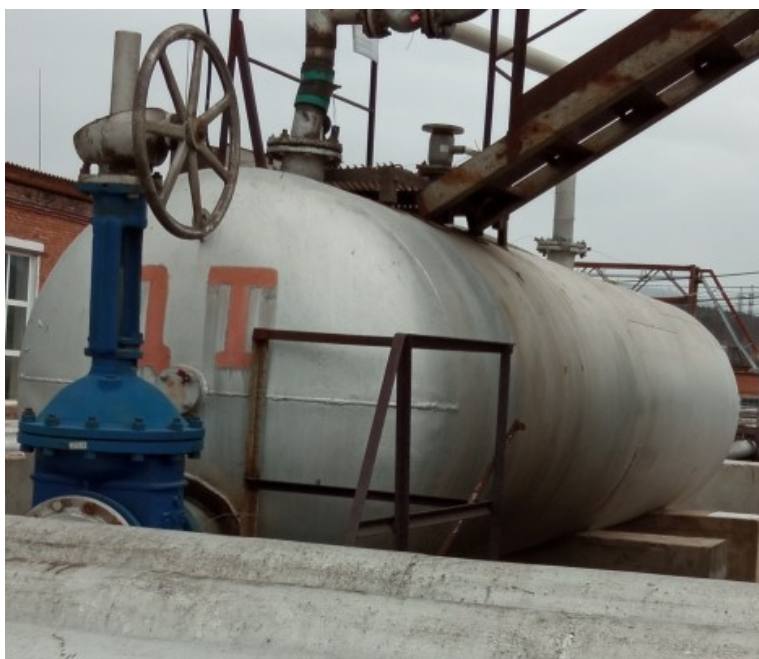
Рисунок 1 – Общий вид резервуара
