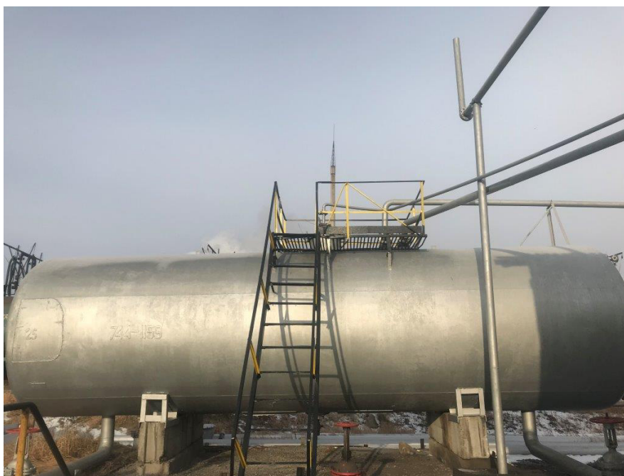
Рисунок 1 – Общий вид резервуара РГС-60
