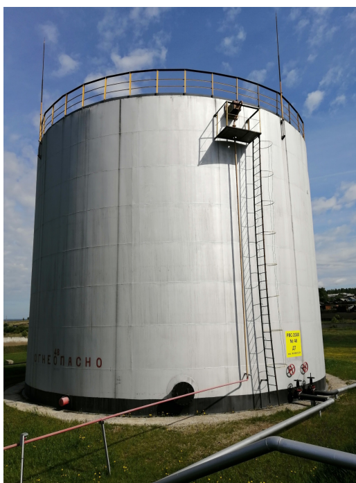
Рисунок 1 – Общий вид резервуара РВС-2000
