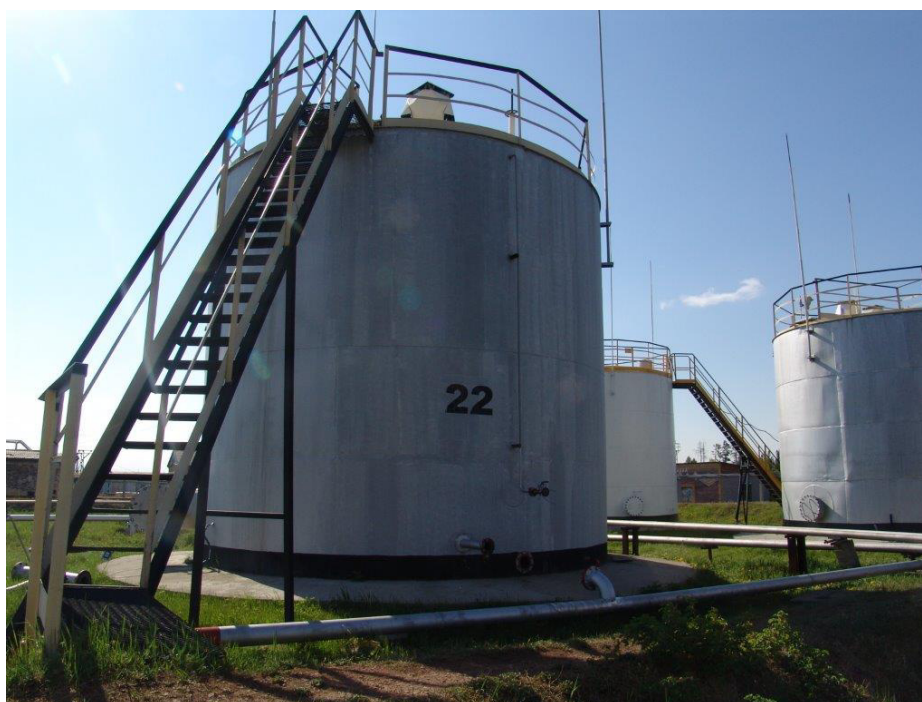
Рисунок 1 – Общий вид резервуара РВС-200
